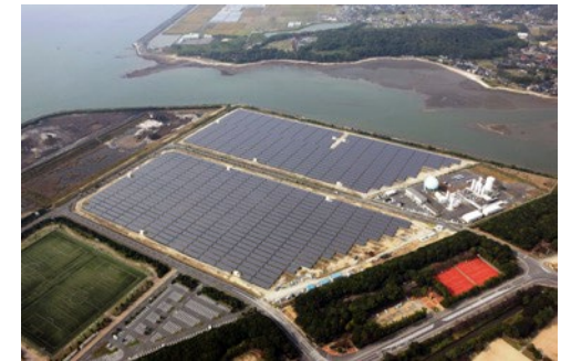
八戸太陽光発電所
