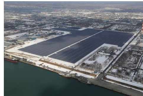
苫小牧太陽光発電所
